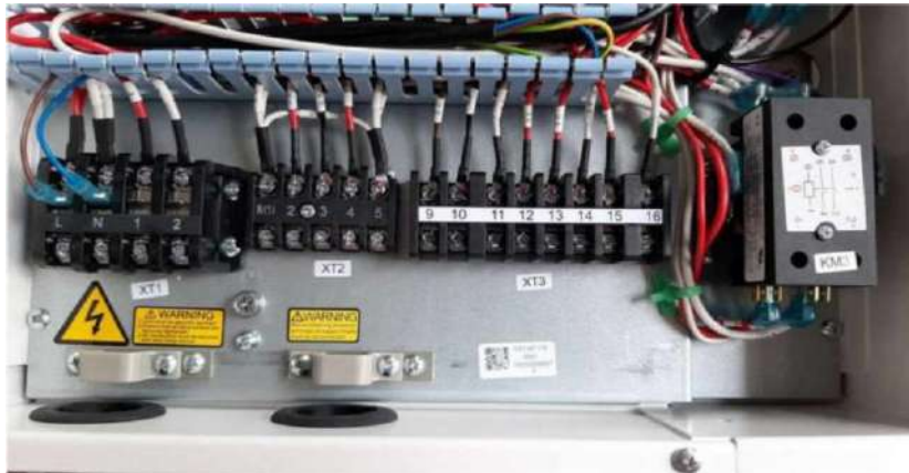
Wygląd części elektrycznej jednostki wewnętrznej
