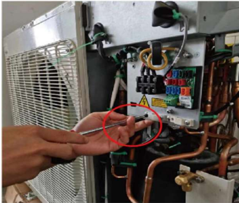
Odkręcanie obejmy zaciskowej przewodów jednostki zewnętrznej
